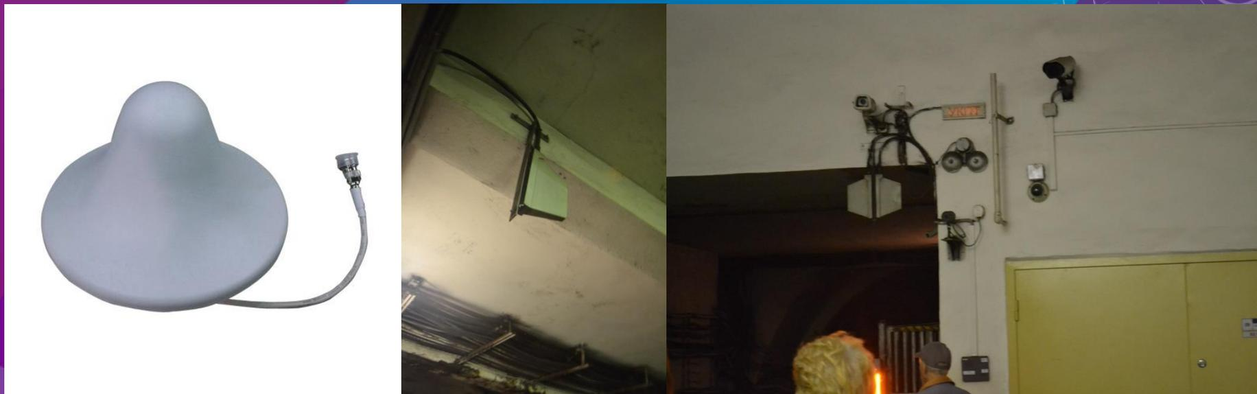
АНТЕННЫ С ВЕРТИКАЛЬНОЙ ПОЛЯРИЗАЦИЕЙ (V-POL) В СЕТЯХ СВЯЗИ ИСПОЛЬЗУЮТСЯ В ОСНОВНОМ ДЛЯ ОРГАНИЗАЦИИ ПОКРЫТИЯ ВНУТРИ ПОМЕЩЕНИЙ (INDOOR). АНТЕННЫ V-POL ВЫПУСКАЮТСЯ КАК НАПРАВЛЕННЫЕ, ТАК И ВСЕНАПРАВЛЕННЫЕ.
